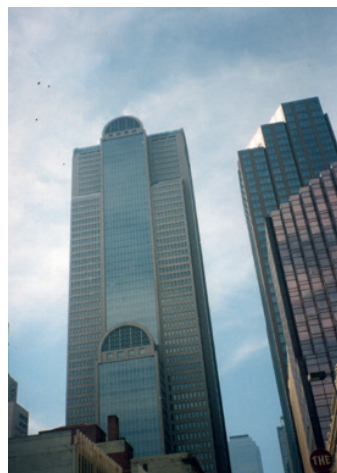
Das Bürogebäude in Fort Worth
